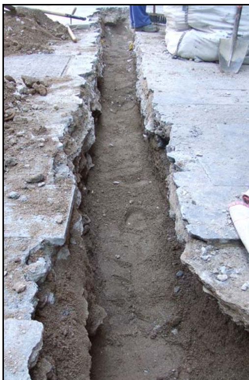
Fotografia núm. 8: Vista de la rasa 300
