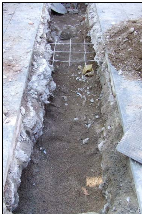
Fotografia núm. 5: Vista de la rasa 200
