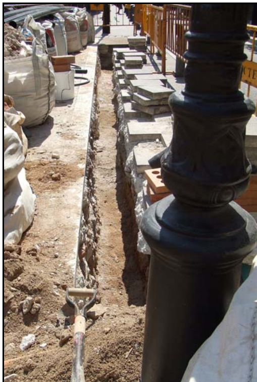
Fotografia núm. 1: Vista de la rasa 100
