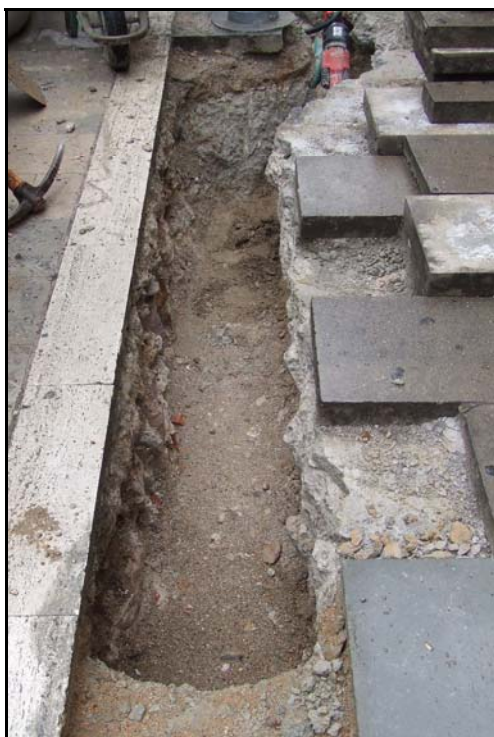
Fotografia núm. 2: vista de la rasa 100
