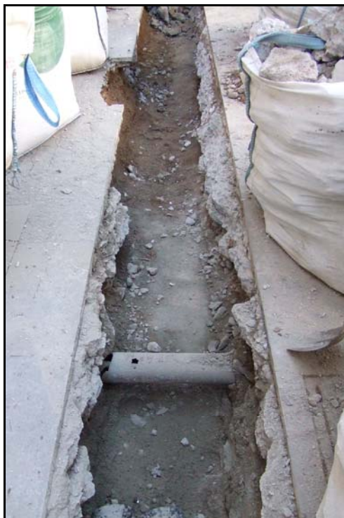
Fotografia núm. 6: Vista de la rasa 200
