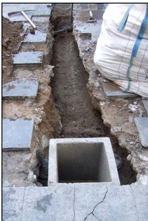
Fotografia núm. 7: Vista de la rasa 300
